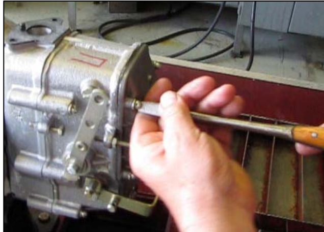
Рис. 3.33 – Снятие крышки смотрового люка
