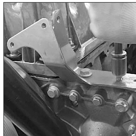
Рис. 137. Установка кронштейна трубы подводящей.
